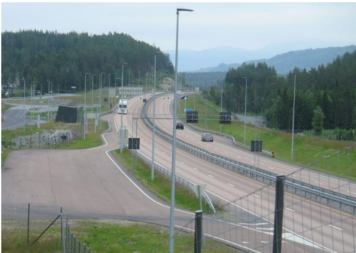
E134 ved Kongsberg er en av strekningene som inngår i det nye vegdriftskontrakten. Foto: Anita Tveiten, Statens Vegvesen
